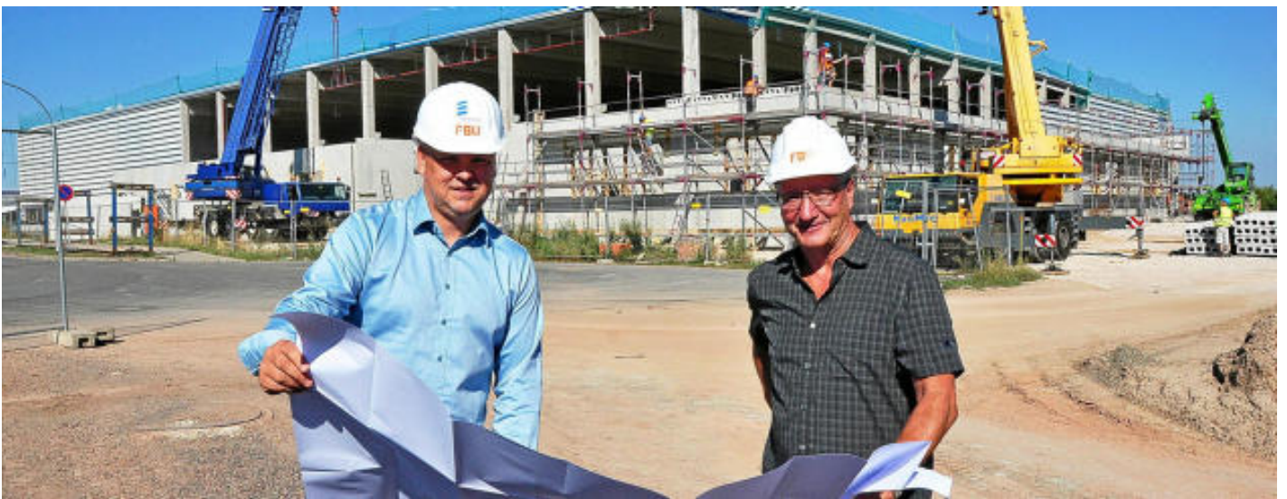
Werkleiter Steffen Reinecke (links) und Bauleiter Gunter Hofmann von der Finsterwalder Bau-Union GmbH. Derzeit wird unter anderem die Hülle des Gebädetraktes geschlossen. Foto: Andreas Schott
