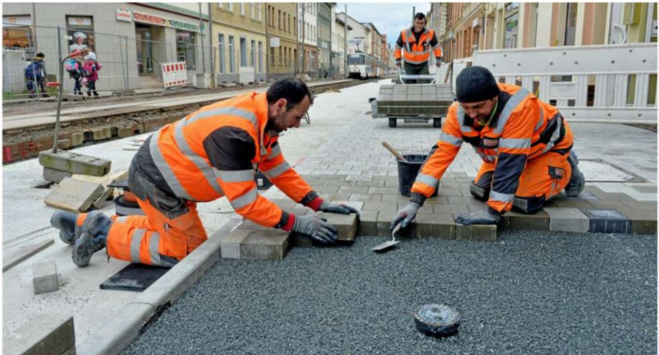
Marcel Kuknat, Jens Bachmann und David Kögler (von links) von der Strabag sind derzeit mit Pflasterarbeiten beschäftigt.
